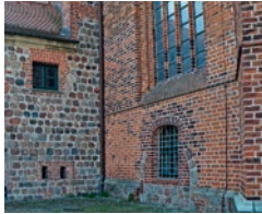
Feldsteinwand der ersten Kirche am Nordenbau des Doms.
