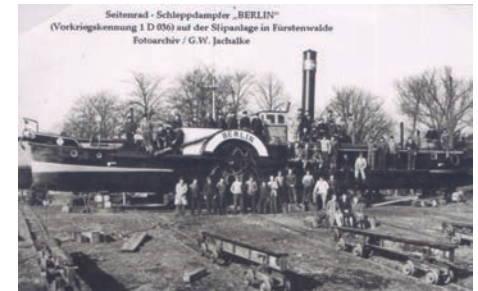
Seitenrad Schleppdampfer „Berlin“ zur Reparatur auf der Slipanlage Fürstenwalde
