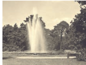
ab 1939 der Springbrunnen
