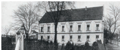
Ritsch- Mühle mit Brunnenanlage, Anfang Trebuser Straße
